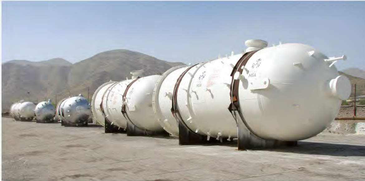
رآکتورهای فاز ۱۴ پارس جنوبی South Pars phase 14 reactors
