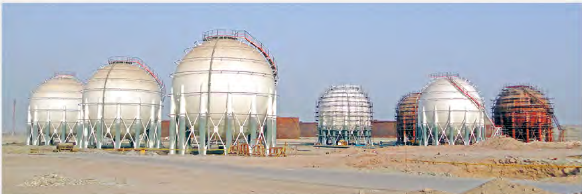
مخازن کروی پالایشگاه ستاره خلیج فارس در مراحل نهایی ساخت Persian Gulf Star Oil Refinery spherical tanks at the end of project
