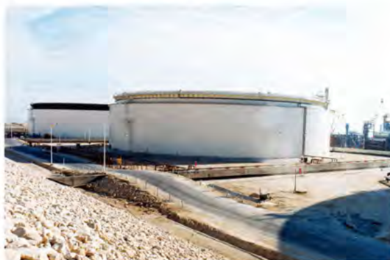
مخازن ذخیره دو جداره فاز های ۲ و ۳ پارس جنوبی South Pars phase 2, 3. double shell storage tanks
